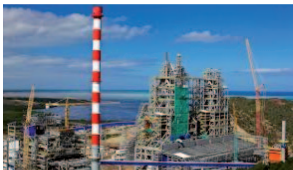
L'usine du nord en construction (Koniambo Nickel SAS), source : Nouvelle Calédonie 1ère
