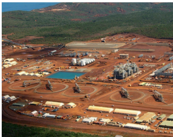
L'usine métallurgique de Goro (groupe Valé NC), source : Nouvelle Calédonie 1ère
