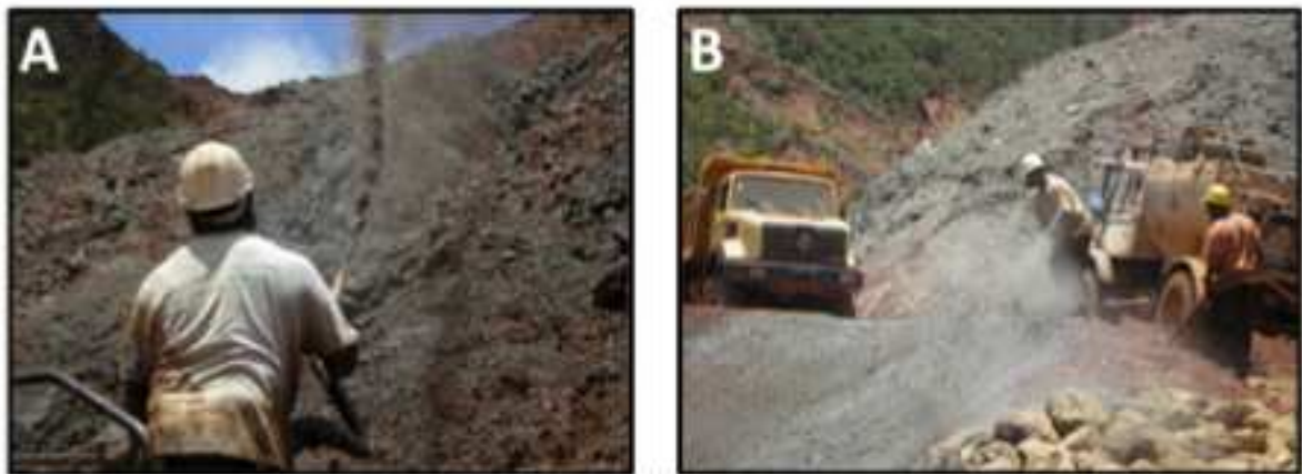
Figure 3 : Ensemencement hydraulique mené par la société SIRAS-Pacifique (© D. Saint-Pierre)
