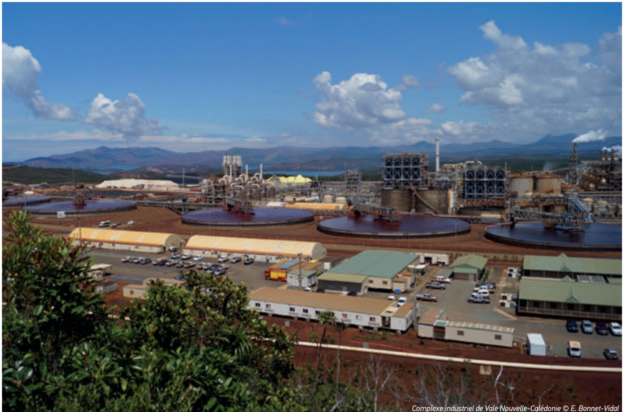
Complexe industriel de Vale Nouvelle-Calédonie © E. Bonnet-Vidal
