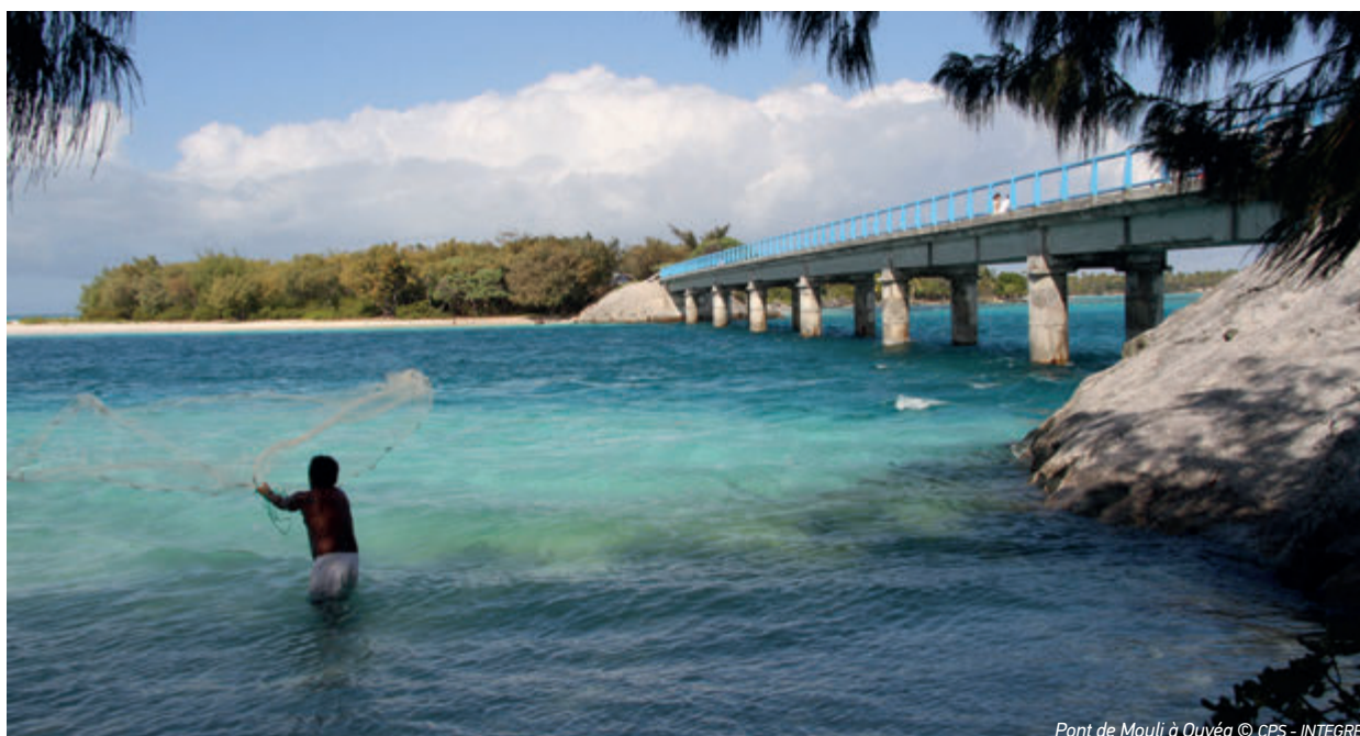
Pont de Mouli à Ouvéa © CPS - INTEGRE
