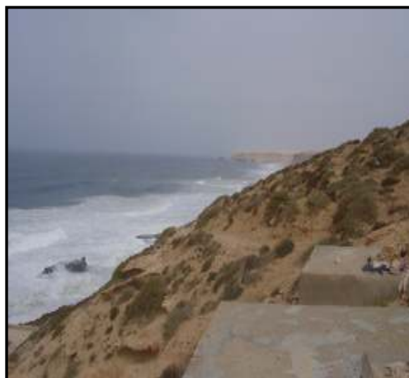
Photo 16 : Les constructions anarchiques le long du littoral accentuent le phénomène de l'érosion éolienne altèrent les paysages.
